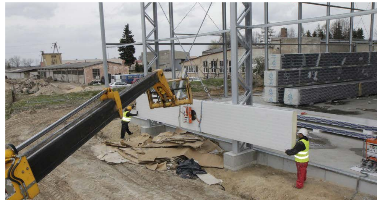
Zdjęcie nr 9. Montaż poziomy ściennych płyt warstwowych.
