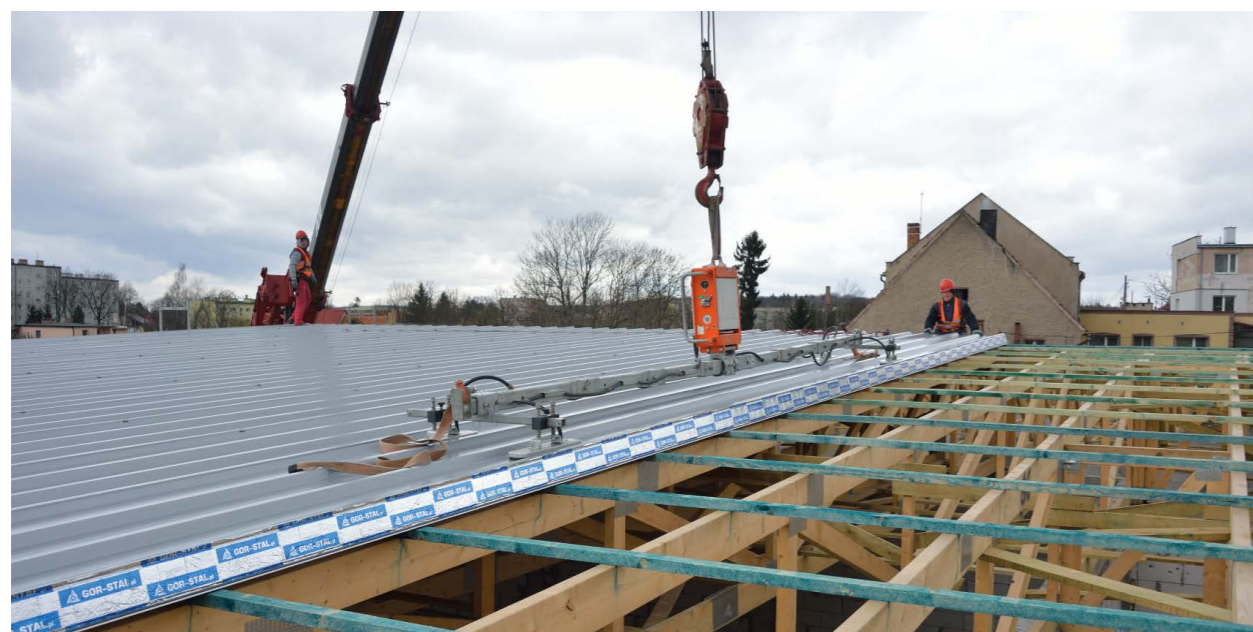
Zdjęcie nr 7. Układanie płyty dachowej na konstrukcji budynku
