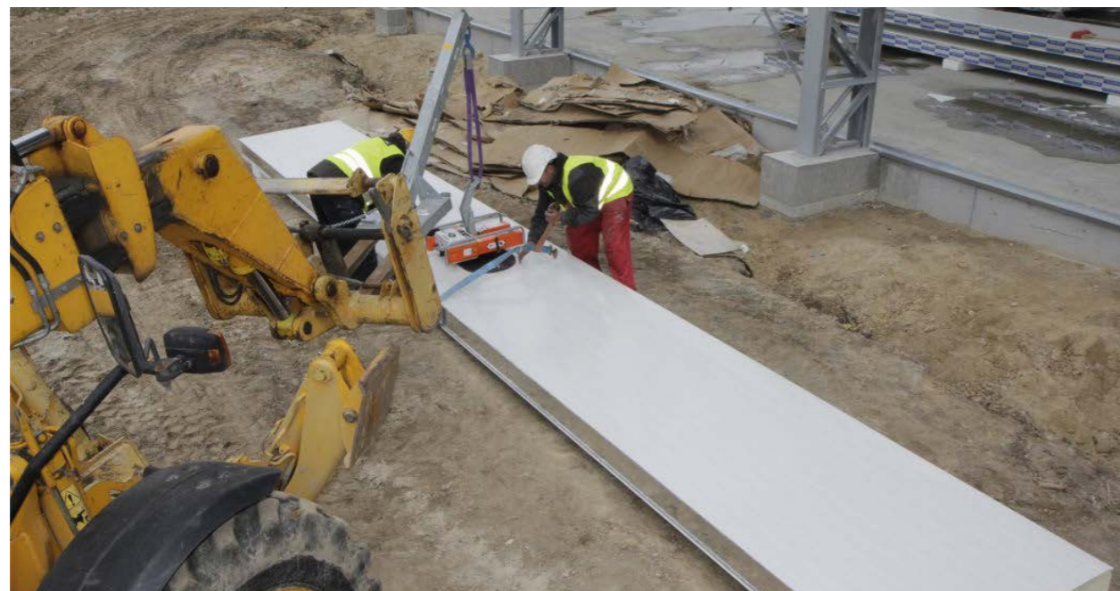
Zdjęcie nr 8. Podnoszenie płyty przyssawką próżniową ze stosu (montaż poziomy).
