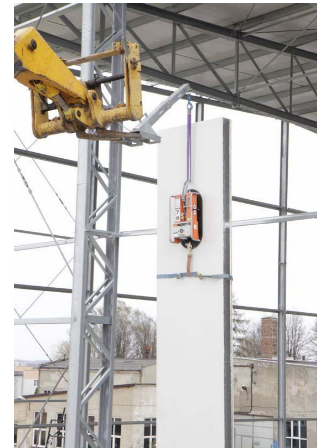
Zdjęcie nr 11. Montaż pionowy ściennych płyt warstwowych.
