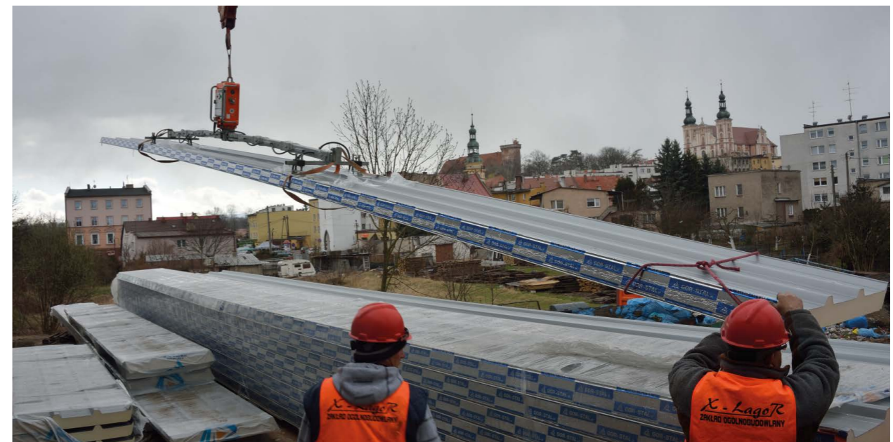
Zdjęcie nr 6. Unoszenie płyty dachowej ze stosu.
