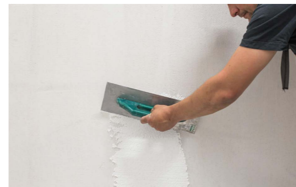
Etap VI b) Układanie warstwy wykończeniowej.
