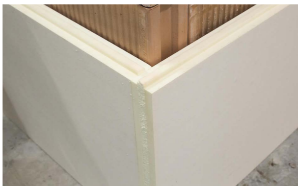
Zdjęcie nr 11. Widok zamontowanych płyt narożnych.
