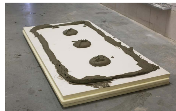
Etap II. a) Ułożenie kleju na płycie.
