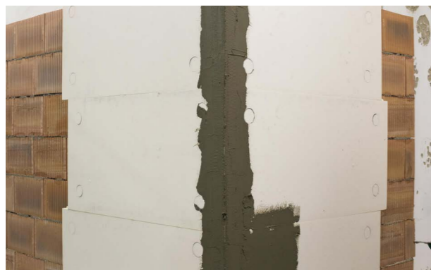
Etap V d) Ułożenie warstwy kleju na ścianie.
