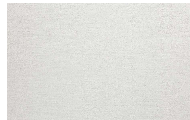
Zdjęcie nr 18. Widok gotowej warstwy wykończeniowej.
