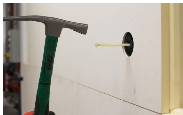
Etap IV d) Montaż trzpienia kołka.
