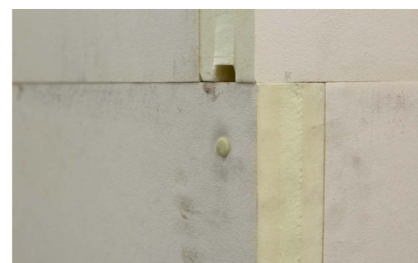
Zdjęcie nr 13. Widok zainstalowanego elementu zabezpieczającego narożnik.
