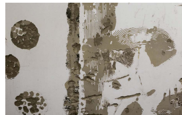
Zdjęcie nr 1. Ubytki do wypełnienia klejem.
