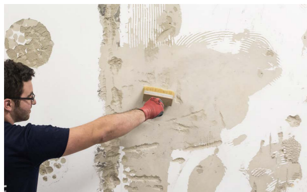
Etap II. Odpylenie podłoża.
