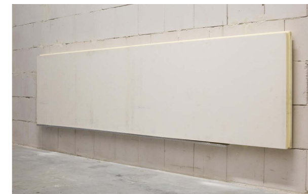
Zdjęcie nr 6. Widok na ustawione płyty.
