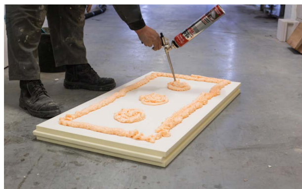
Zdjęcie nr 8. Ułożenie kleju poliuretanowego na płycie.
