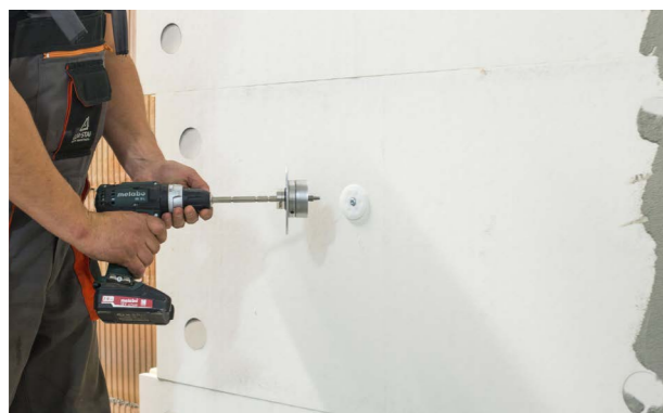
Etap IV c) Zagłębienie kołka w warstwie termoizolacyjnej.
