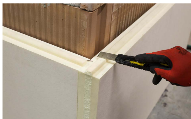
d) Usunięcie pióra płyty narożnej.
