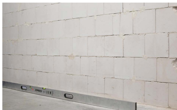
Etap I. a) Wyznaczenie położenia listwy startowej.
