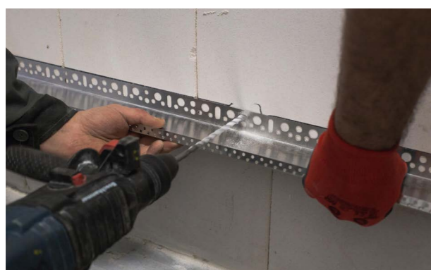
Etap I. b) Ustawienie i montaż listwy startowej.
