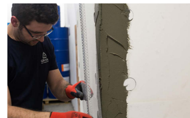
Etap V c) Montaż narożnika gotowego.
