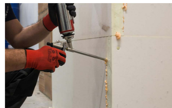
Etap V a) Wypełnienie szczelin niskoprężną pianą poliuretanową.
