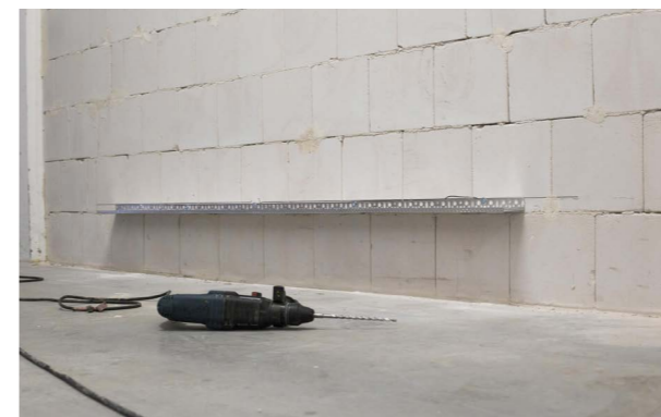
Zdjęcie nr 5. Prawidłowo zamontowana listwa startowa.
