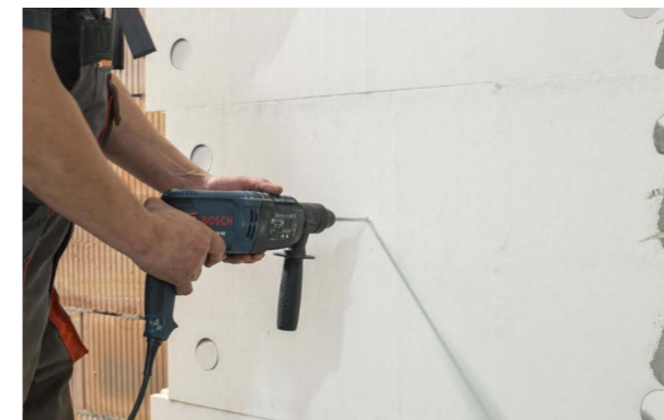
Etap IV a) Przygotowanie otworu w ścianie pod koszulkę kołka.
