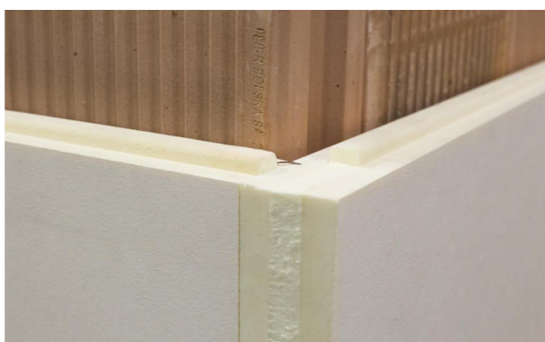
Zdjęcie nr 12. Widok płyt przygotowanych do montażu kolejnego rzędu.
